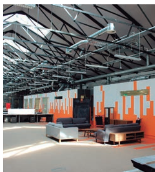
Rozwiązanie wybrane przez firmę Zalando na potrzeby przekształcenia powierzchni magazynowej na biuro. Grand Canal Quay, Dublin. ECOi
